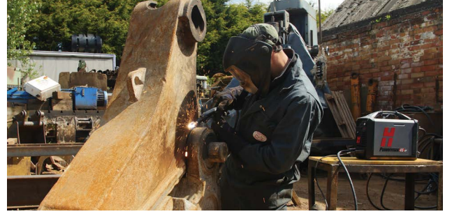
Bakım ve onarım
